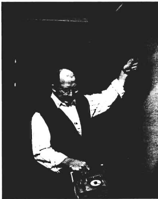
Mätning av magnetiska växelfält i elrännor i taket.
